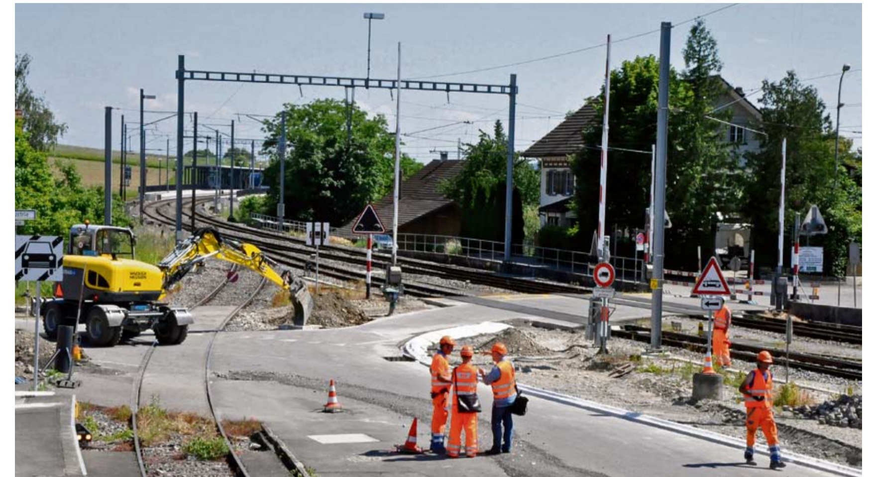
Nach vielen Verhandlungen zwischen Polizei, Gemeinde, ZVV und SBB wird nun der Bahnübergang beim alten Bahnhof Marthalen fertiggestellt.
