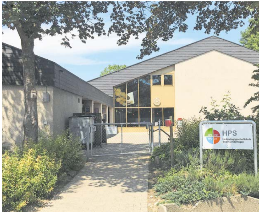
Die HPS in Humlikon wird saniert. Im nächsten Jahr ist das Dach dran. Bild: Archiv
